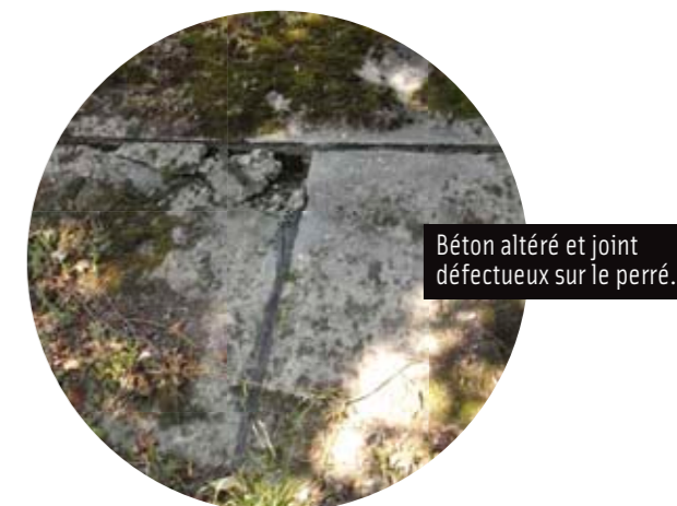
À Grenoble, le perré en contrebas du chemin de halage.
