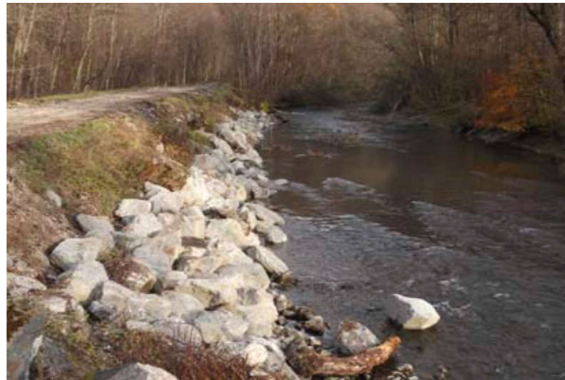
À la Fonderie, le pied de digue côté rivière a été conforté par l'ajout d'enrochements (1).
