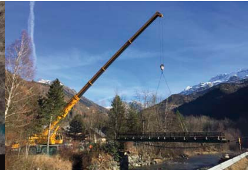
Décembre 2016 : dépose de la passerelle de la Pernière-Haute (3).
