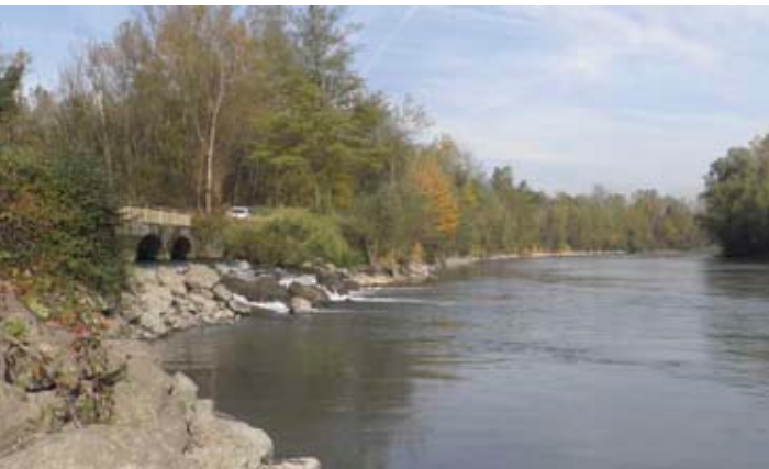
La chute de l'ouvrage à la confluence avec l'Isère en condition d'étiage avant les travaux : le radier présente un décroché important, empêchant la montaison de nombreuses espèces dans le canal.
