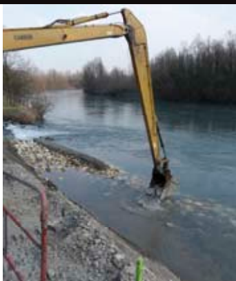
Une pelle à long bras met en place des blocs d'enrochement.
