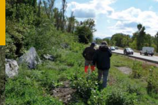
Au Pont-de-Claix, les blocs en attente d'enlèvement.
