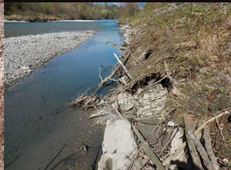
En rive droite du Drac au niveau de Comboire, l'affouillement s'étire sur 80 m. Par endroits, le courant a ouvert des cavités et déplacé des blocs.
