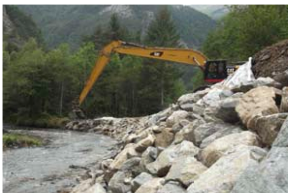
L'enrochement de la même courbe, vu de l'aval.
