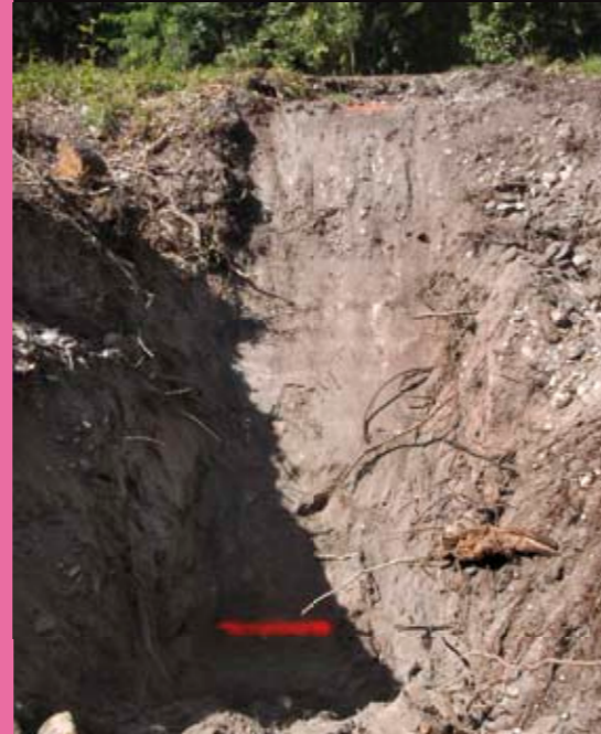
Déboisement de la zone et sondage du perré à Veurey.
