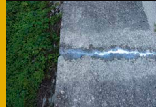
Le traitement des fissures par l'entreprise Carron.
