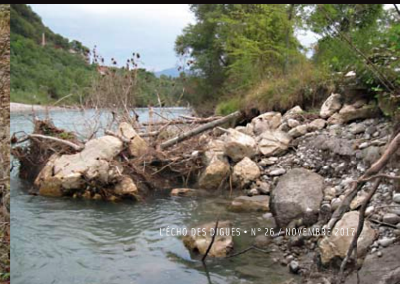
En rive droite du Drac au niveau de Comboire, l'affouillement s'étire sur 80 m. Par endroits, le courant a ouvert des cavités et déplacé des blocs.
